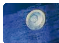
Vanadium Reparaturstopfen in einem Kessel
